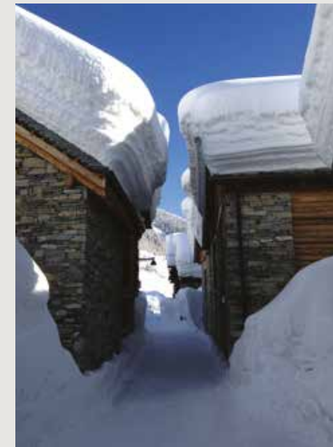
Les structures porteuses subissent souvent de fortes charges, notamment dues à la neige: maisons enneigées à Bosco Gurin (TI). (© Ruth Tomamichel)
