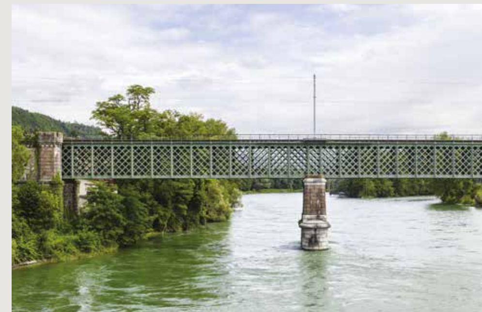
Depuis 1859, la structure en treillis du «Gitterlibrücke» enjambe le Rhin près de Koblenz AG. (© Georg Aerni)
