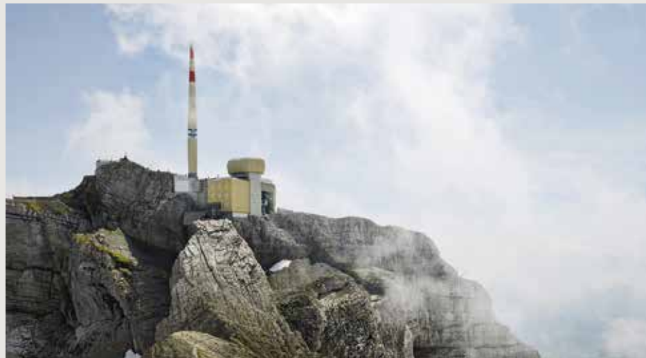
Gare d'arrivée du funiculaire du Sântis, Schwägalp (AR), construit en 1968-1974 par Esther et Rudolf Guyer (photo Sebastian Heeb, Patrimoine suisse)
