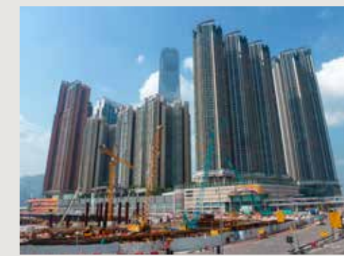
Chantier à Hong Kong (© Ulf Meyer)
