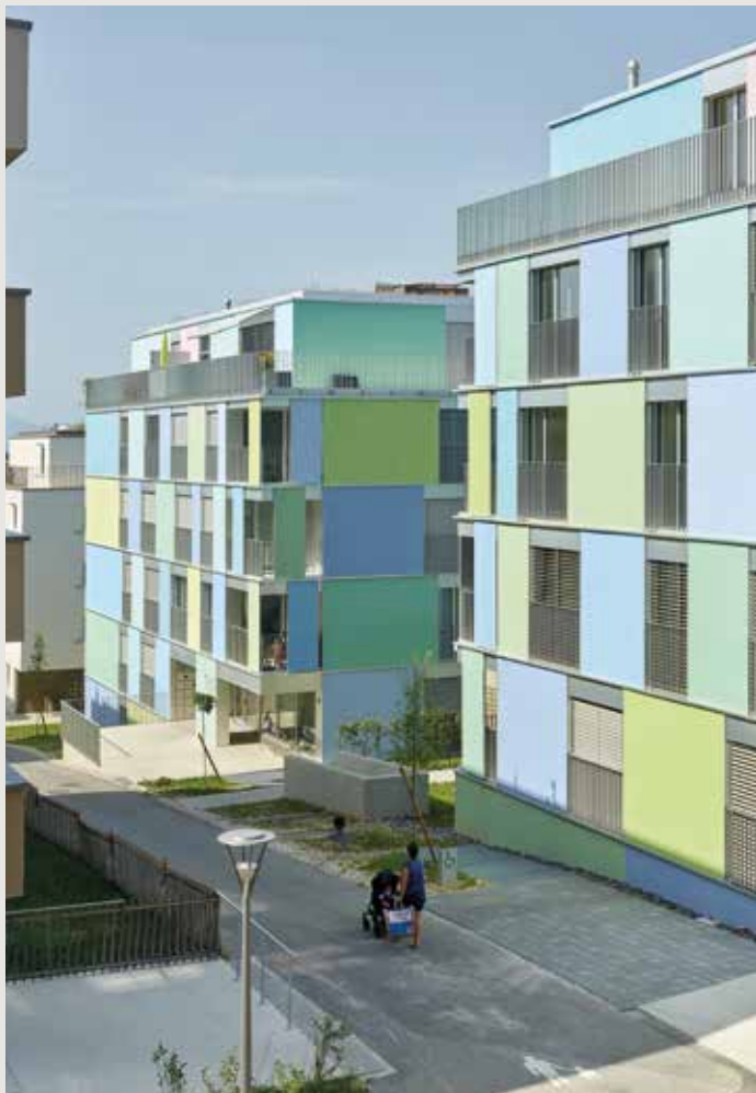
Conçu par le bureau Butikofer de Oliveira Vernay Sàrl de Lausanne, l'éco-quartier lausannois des Fiches Nord offre 64 logements de tailles diverses répondant aux besoins des aînés et des personnes à mobilité réduite. (Photo Thomas Jantscher)
