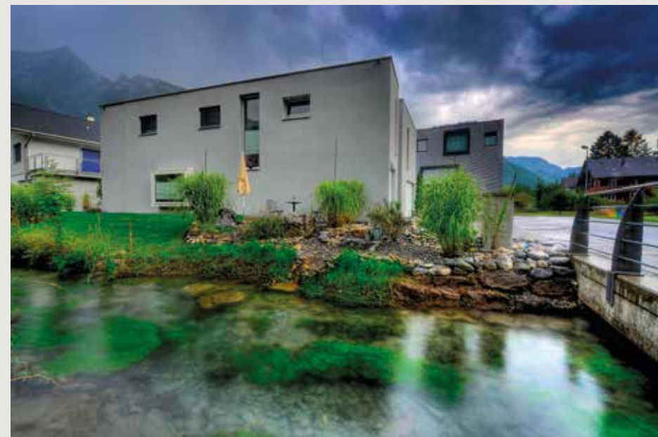
Une tempête ou de la grêle en vue ? Le mieux est de se prémunir dès la conception des ouvrages. (Photo source VKF)
