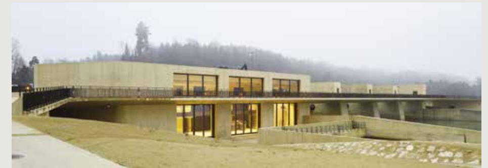
La salle des machines de la centrale électrique de Hagneck est intégrée au barrage. Le franchissement du barrage fait office de trait d'union cyclable entre les deux berges du lac de Biene. (Photo Hannes Henz)
