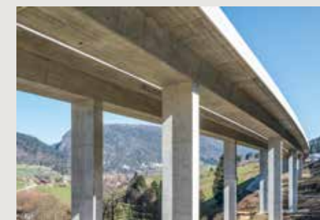
La culture du bâti couvre aussi l'insertion de l'ouvrage dans le paysage, comme le viaduc Eaux des Fontaines à Court (photo Johannes Marburg)
