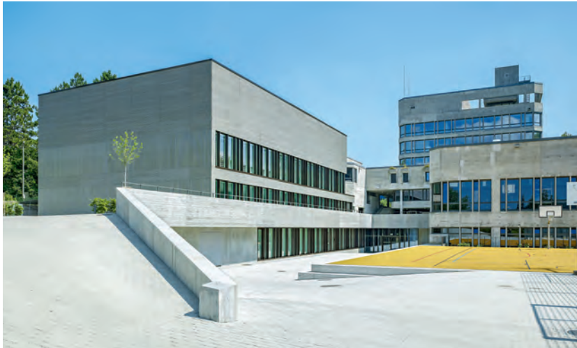
War 2014 zu besichtigen: die von Sabarchitekten aus Basel geplante Doppelturnhalle des Gymnasiums Liestal BL.
