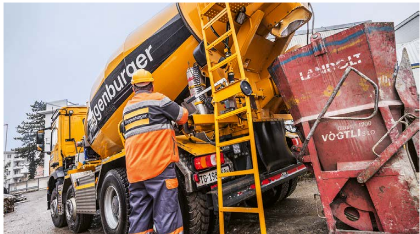
Der flüssige Beton, der aus dem Fahrmischer kommt, ist ein normiertes Produkt. Wasser sollte daher nur gemäss einem dokumentierten Verfahren zugegeben werden.
