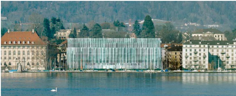
Der Mythenquai mit dem Swiss-Re-Neubau der Basler Architekten Diener&Diener.
