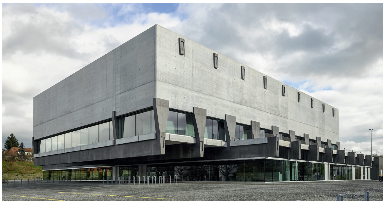
Sporthalle Weissenstein: Die statischen Elemente des Sichtbetonbaus wurden mit einer Lasur aus Grafit hervorgehoben.
