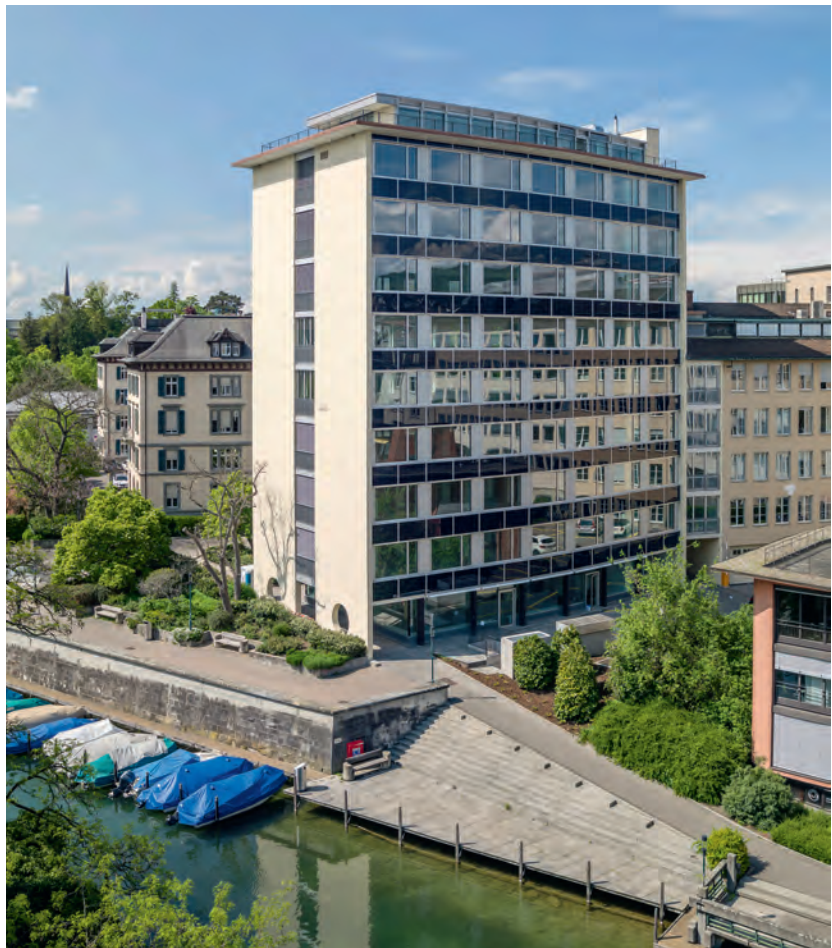
Das sanierte Hochhaus «Zur Bastei» am Zürcher Schanzengraben.
