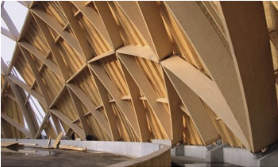
01 Innovativer Ingenieurholzbau: Saldome, Möhlin (Häring & Co AG, Pratteln) (Foto: Jürg Fischer)
