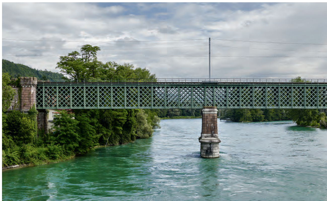
Seit 1859 überspannt die «Gitterlibrücke» mit filigranem Diagonalfachwerk bei Koblenz AG den Rhein. Jetzt will die Deutsche Bahn die älteste Bahnbrücke zwischen Deutschland und der Schweiz abbrechen.
