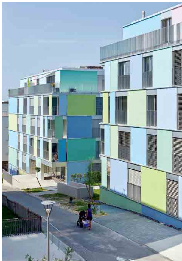
Das «Ecoquartier les Fiches Nord» in Lausanne von Butikofer de Oliveira Vernay, Lausanne, bietet 64 Wohnungen in verschiedenen Grössen und ist auf Bedürfnisse von Senioren und Personen mit eingeschränkter Mobilität angepasst.
