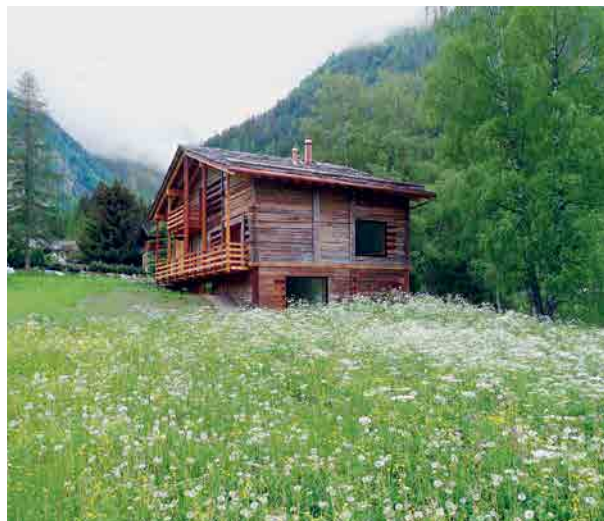
Der Umbau einer Scheune in Orsières VS von LR architectes, Lausanne, ist ein Beispiel der Umnutzung eines ehemals landwirtschaftlichen Gebäudes im alpinen Raum.
