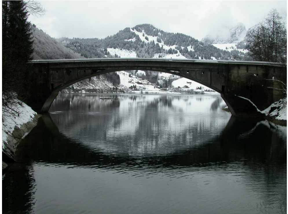
Schrähbachbrücke in heutigem Zustand
