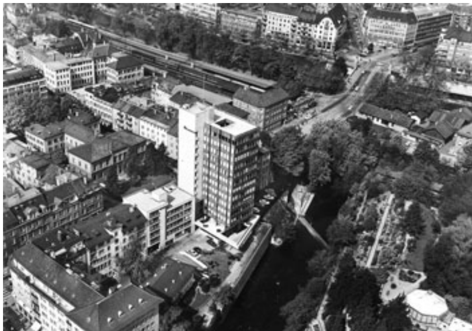
01 Nach langwierigen Verhandlungen mit den Baubehörden konnte der SIA 1970 endlich seinen heutigen Standort an der Selnaustrasse 16 beziehen (Foto: Archiv SIA)
