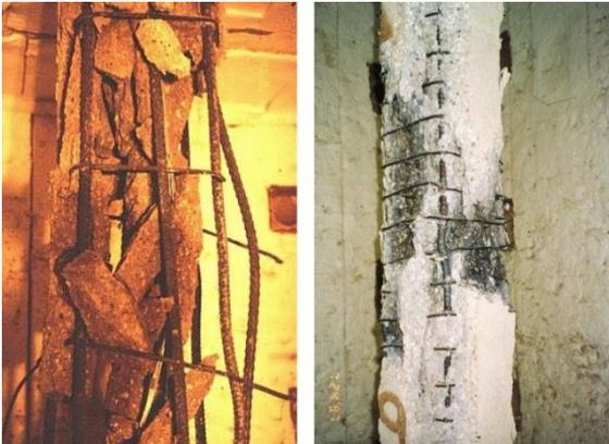
Figure 3 Réduction de l'écaillage par le resserrement des étriers bien ancrés [13]
