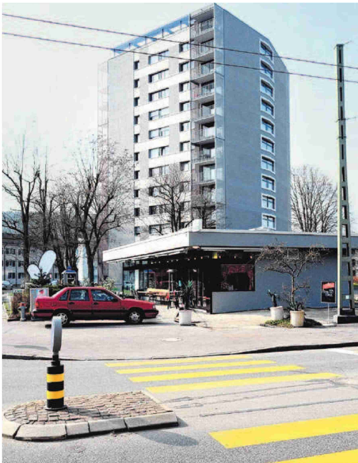
Der schmale Kopfbau (gegen rechts) vergrößerte das Bauvolumen, ohne dass Freiflächen verloren gingen. Bild: Marc Dahinden
