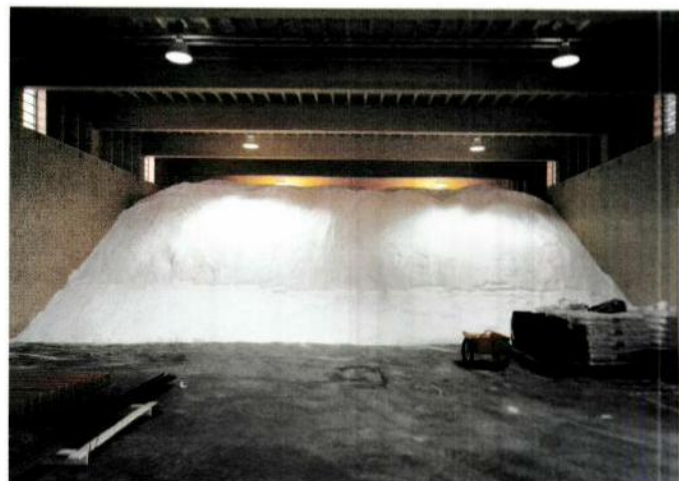
Abb. 8: Autobahnwerkhof Bursins (Vaud).
