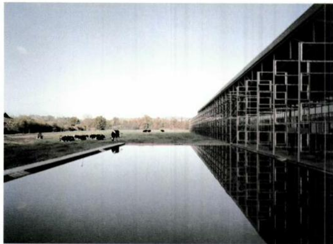
Abb. 2: Werkerweiterung der Fensterfabrik Hagendorn (Zug).
