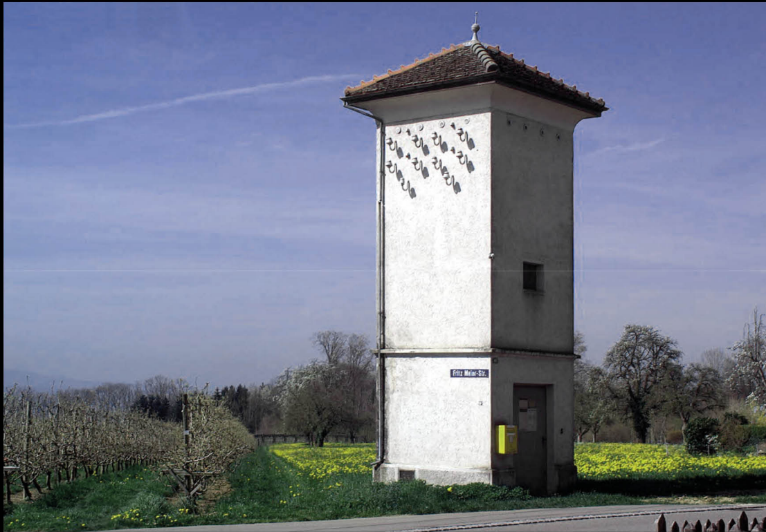
Umnutzung Trafostationen, Thurgauer Heimatschutz, Ideenwettbewerb 2007
